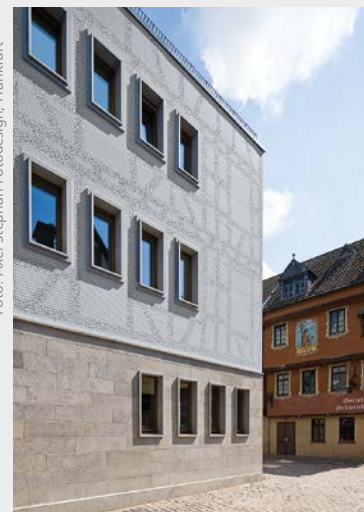
Eine gedämmte Fassade mit „Zitterstrich“: die Kleine Rittergasse.
